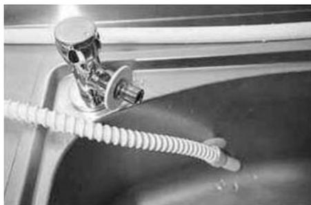
Опустите конец дренажной трубки в раковину и зафиксируйте его присоской на стенке раковины.
